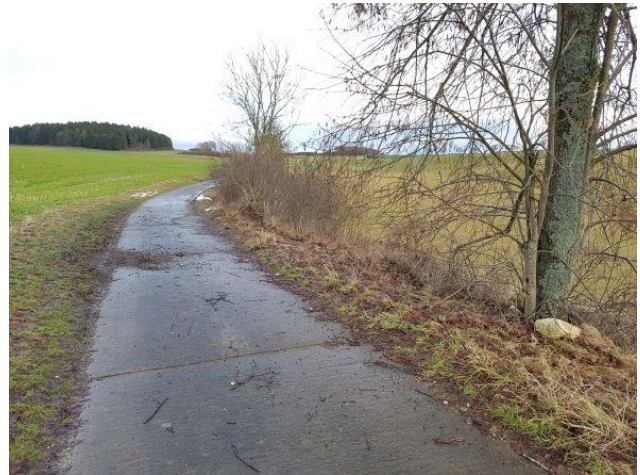
Foto 4: Wirtschaftsweg mit Betonplatten entlang der südlichen Plangebietsgrenze. Blick nach Osten.
